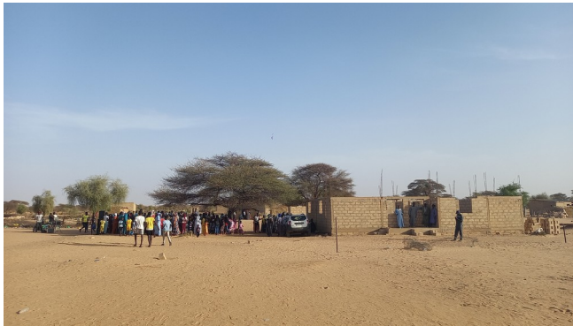
Poste de sante de Nianga Diéry
